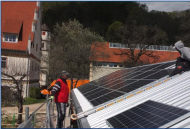
Montage der neuen Photovoltaikanlage auf dem Dach des Pferdestalls.
